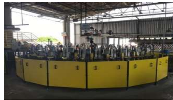
NR-12 – Protección de máquinas
